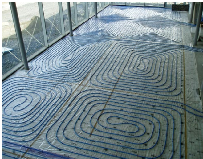
Inštalácia vykurovacích slučiek na extrudovaný polystyrén fixačnými príchytkami IVAR.PPA
