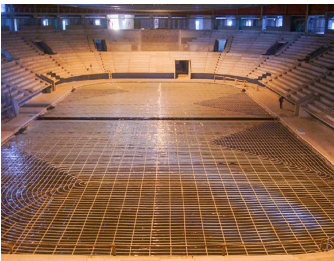
Inštalácia vykurovacích slučiek na podklad betón s využitím fixačnej hrebeňovej lišty IVAR.WL
