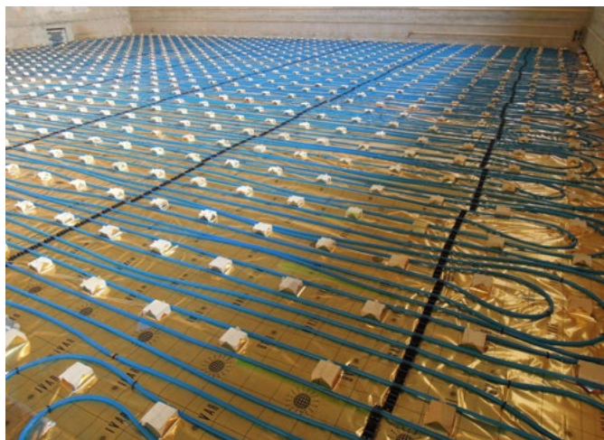
Inštalácia rúrok na reflexnú fóliu IVAR.FR fixačnými príchytkami IVAR.PPA
